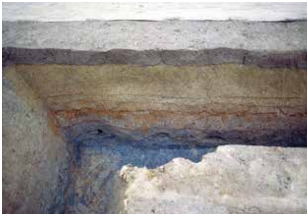
調査区西壁南端部 土層断面（東から）
