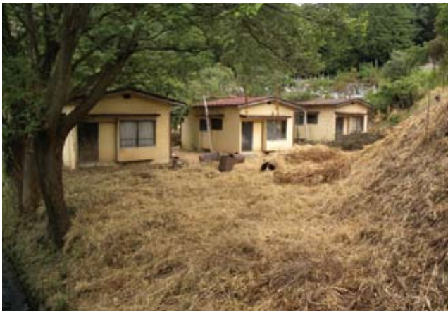
解体前の平屋住宅（西から）
