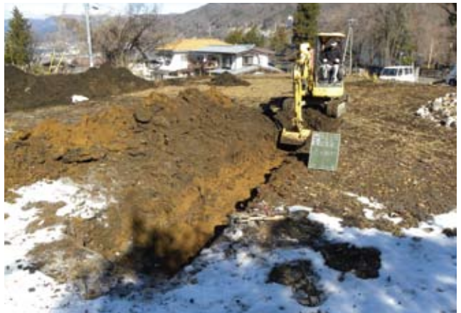
重機による表土掘削の様子（3 トレンチ、南から）
