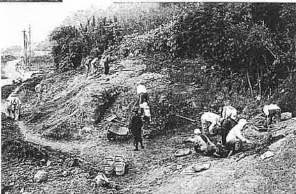
■ Photo. 2 調査作業風景 (A～D区)
