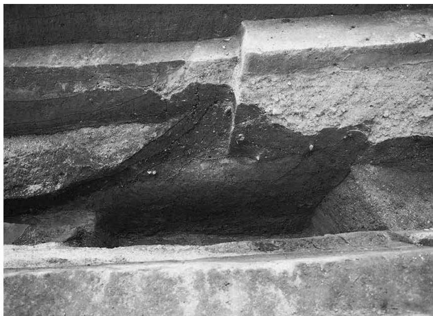
堤状遺構 盛土断ち割り断面②(東より)
