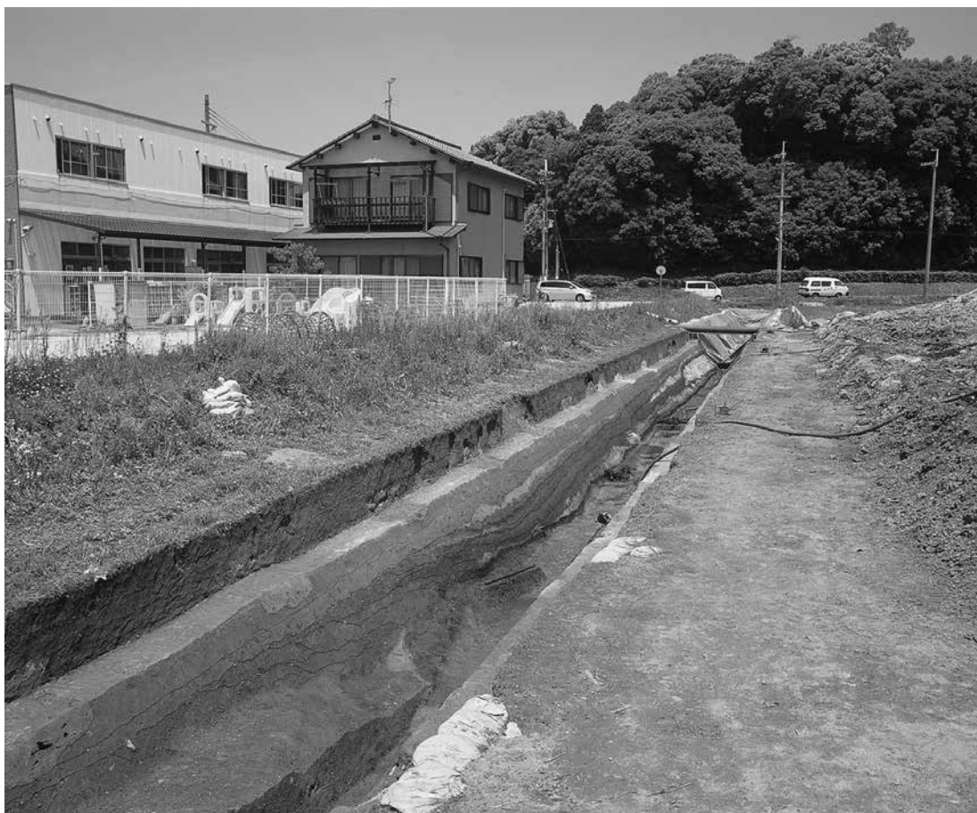
外濠状遺構 埋土断面② (南東より)
