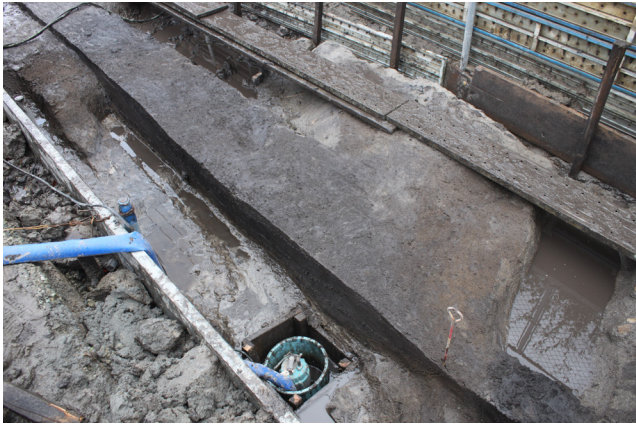
SD04、05 掘削及び土層断面（南西から）
