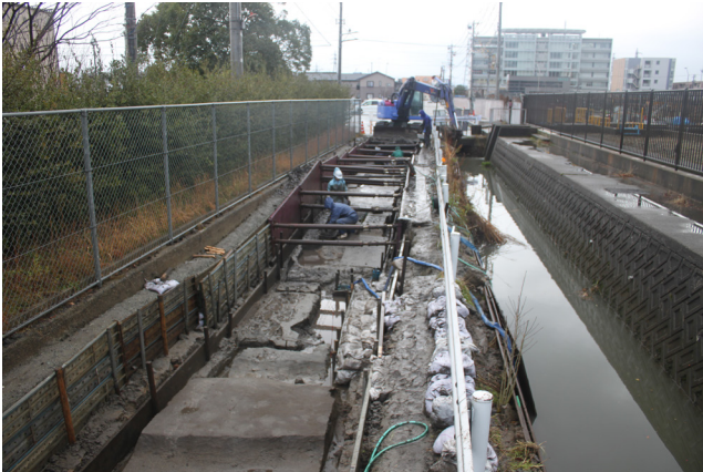
調査区南側掘削状況（北から）
