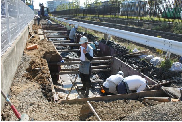
作業状況（北から）
