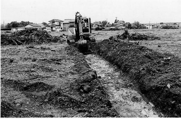
平成12年度詳細分布調査 試掘坑掘削
