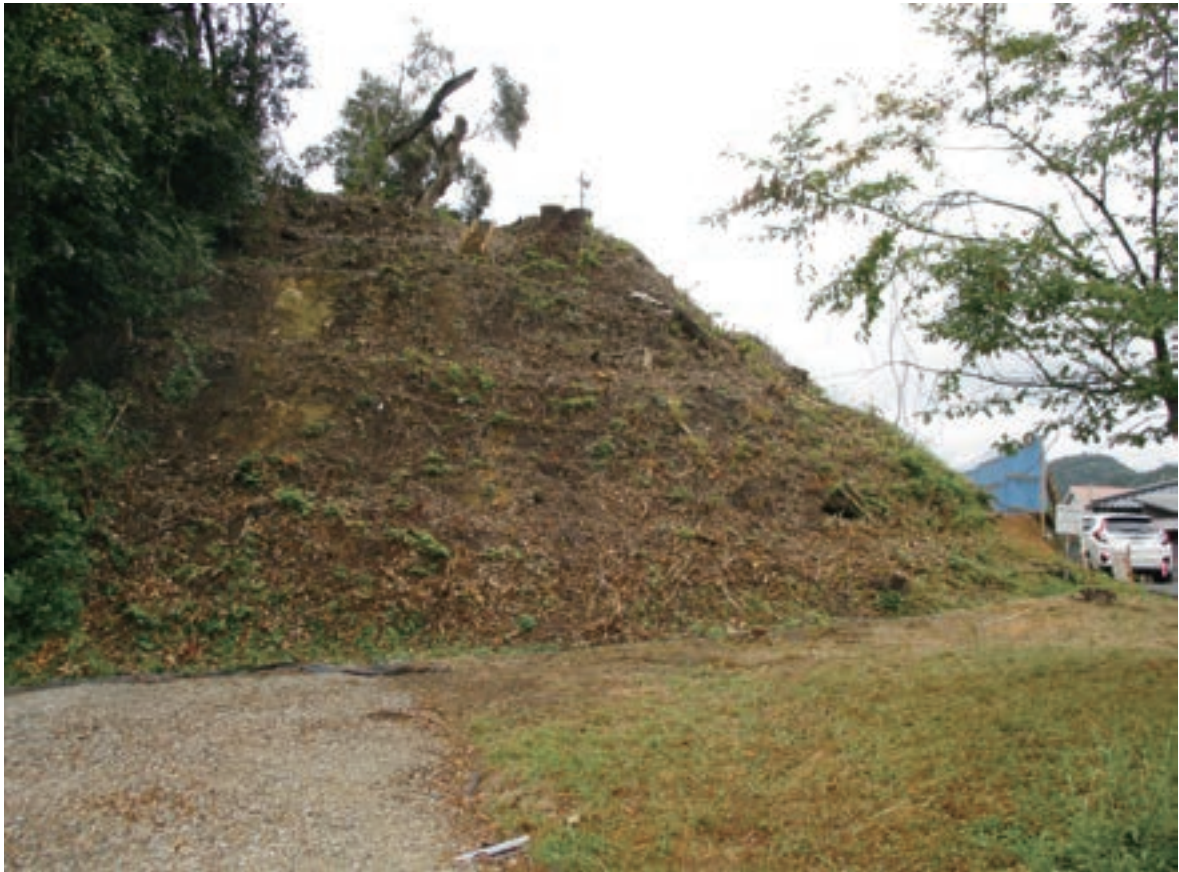
北東側斜面 調査前状況（北東から）
