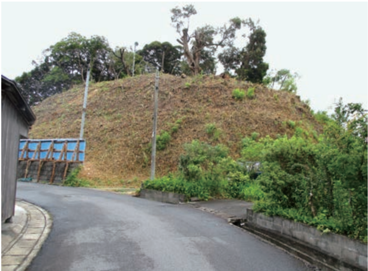
北西側及び南西側斜面 調査前状況（西から）
