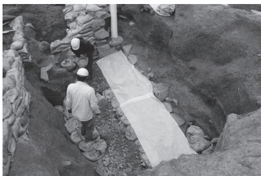
図5 埋戻し作業風景（北から）
