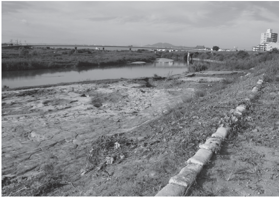
図2 調査前全景（南西から）
