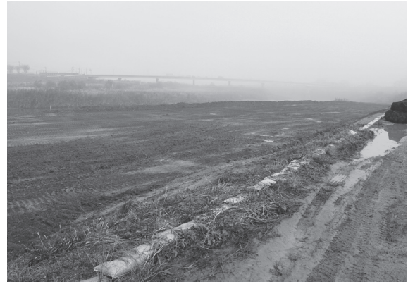
図3 埋戻し後全景（南西から）
