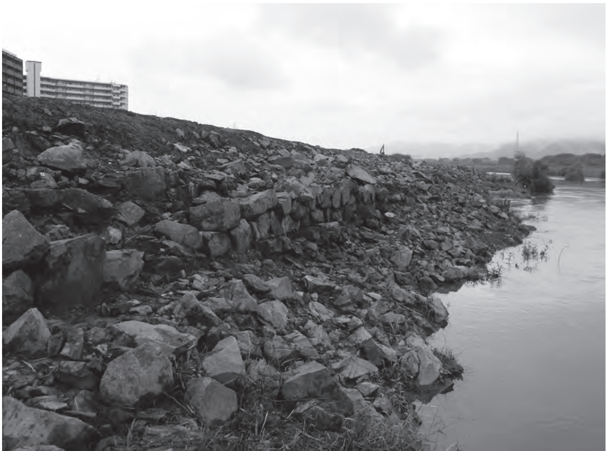
2 石垣全景（北東から）
