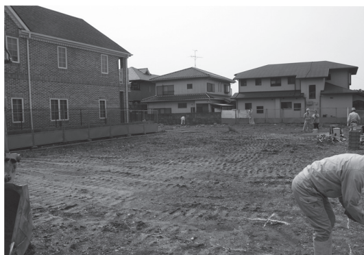
図2 調査前全景(北西から)
