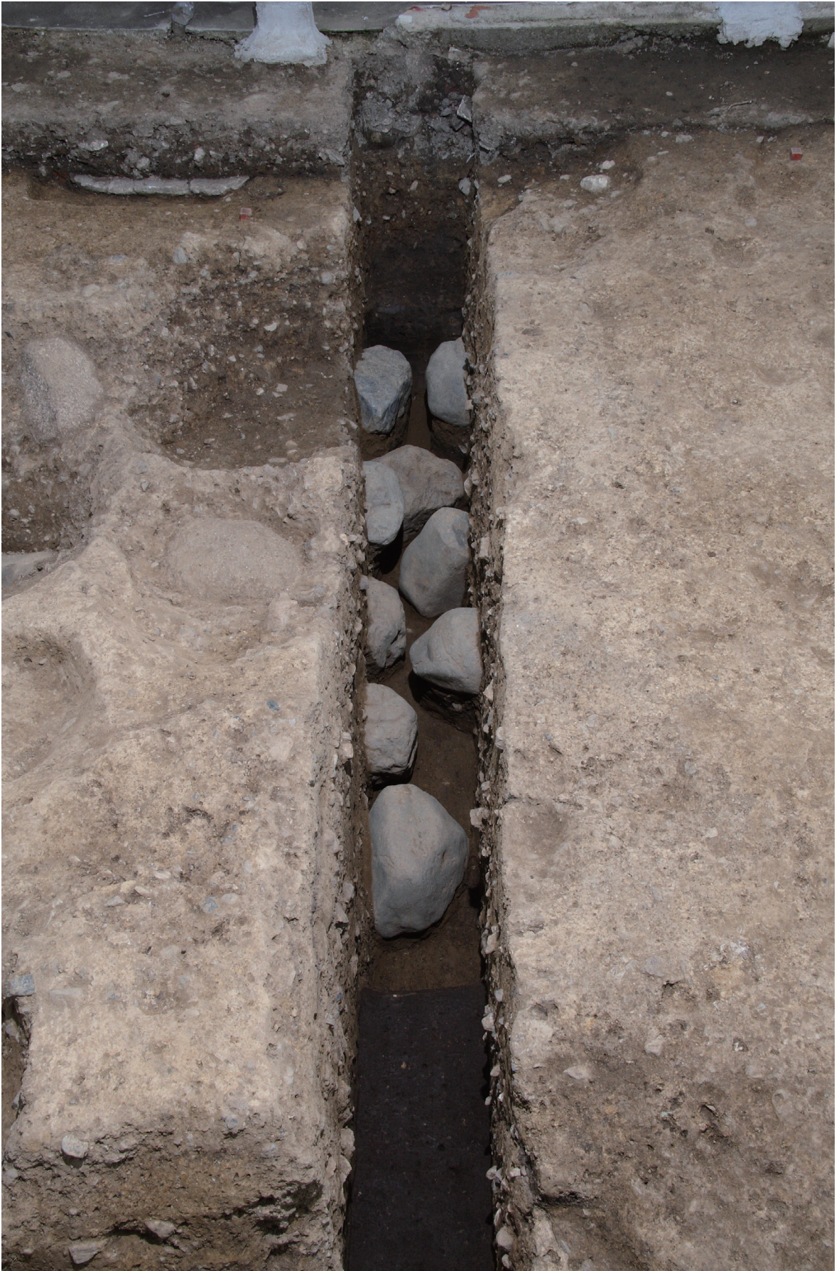
根固め（壺掘地業）2（北から）
