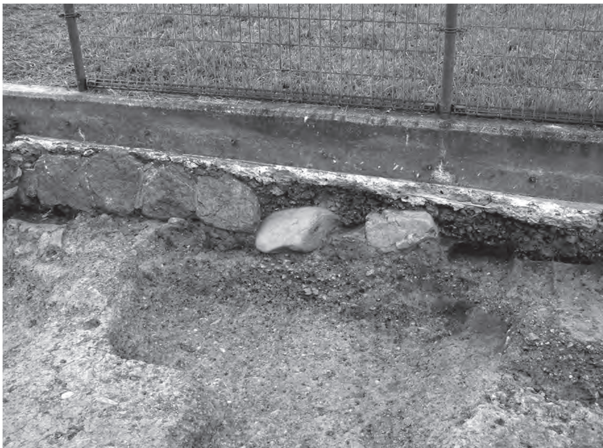
3 根固め（壺掘地業）8（南東から）
