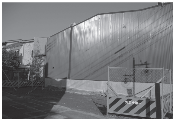
図3 調査前全景(南東から)
