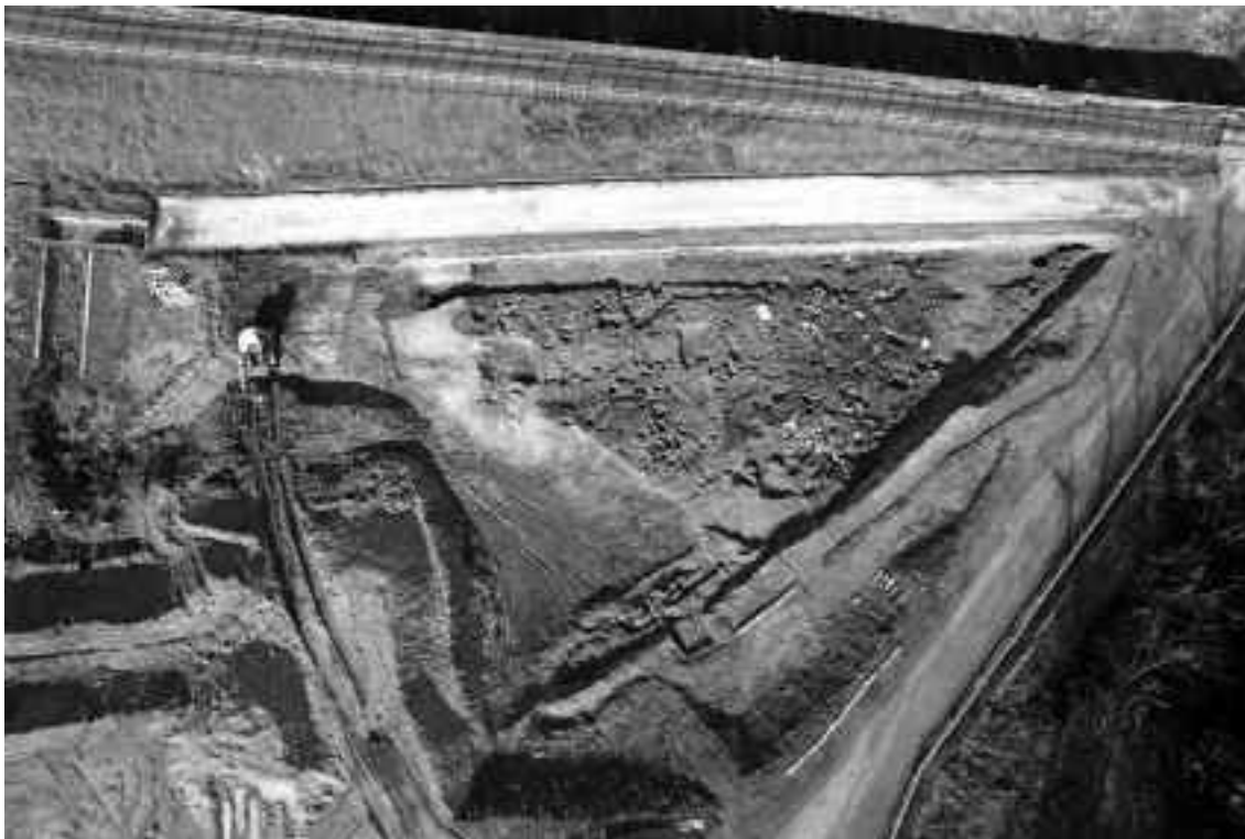
(2) II区調査区近景
