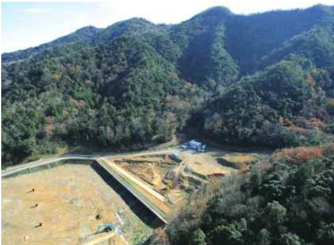
(2) 調査地遠景 (北西から)
