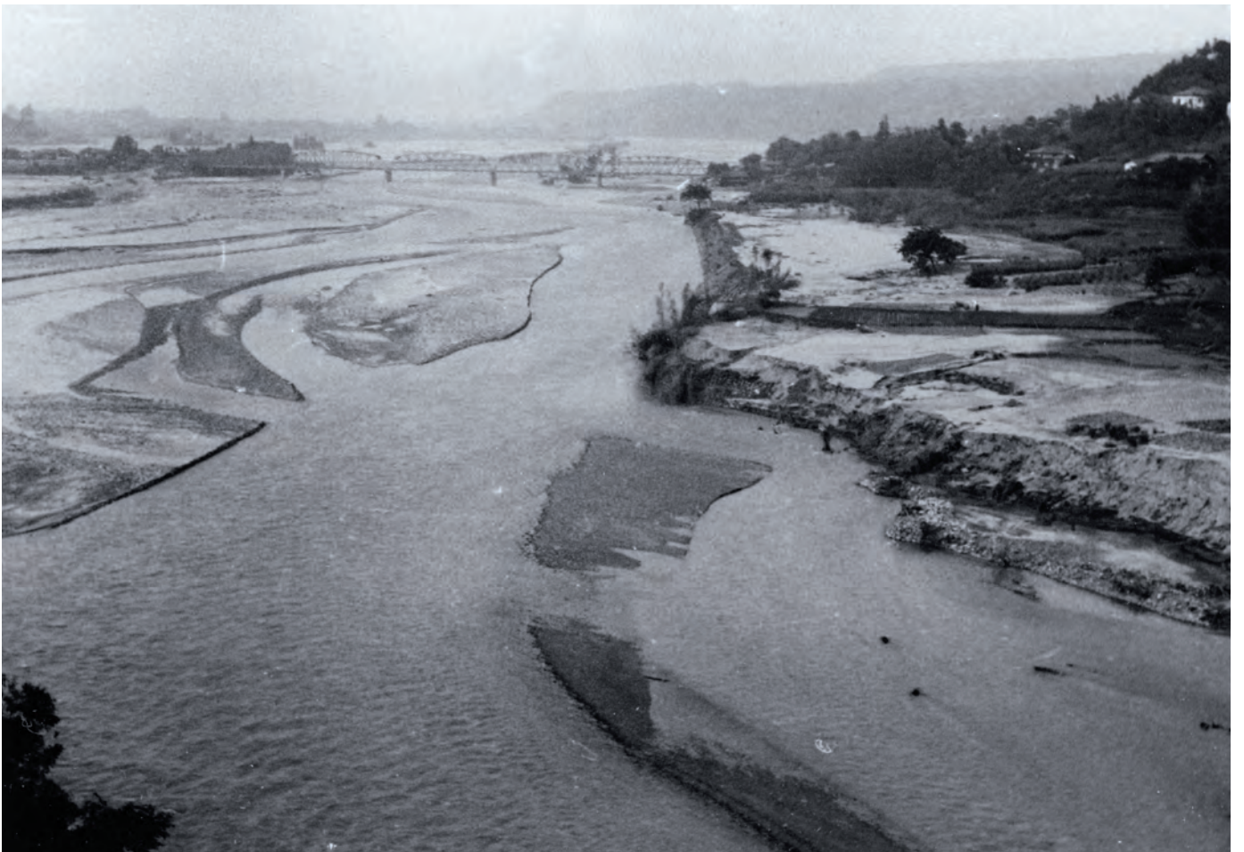
三六災害直後の遠景（南西より）
