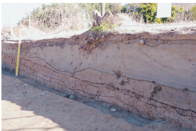
2区7 T南西側断面 (西より)
