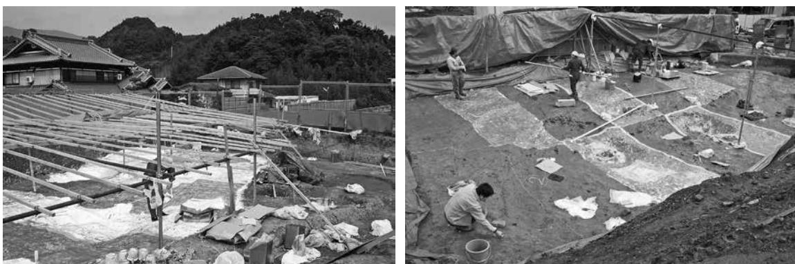
**4 型枠補強**…建物の立体形状を維持するために、建物の表面に塗布したポリエステル樹脂とFRPの変形を防止することを目的として、木製角材を型枠として設置して補強する。
