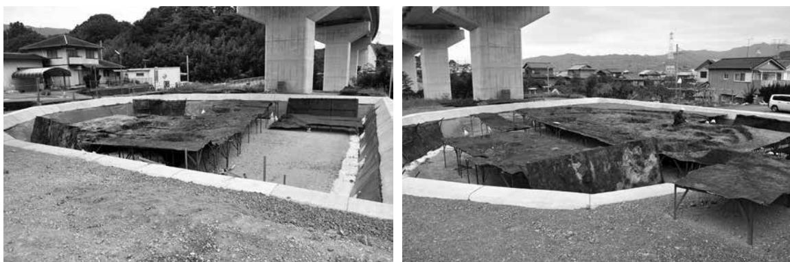
19 部材仮接合…FRP 雄型の移設部材を移設設置坑内に仮設置し、各部材の設置高の位置関係も確認・調整したうえで、位置関係が確定した部材同士を緩衝材の木片を挟んでビスで仮接合する。
