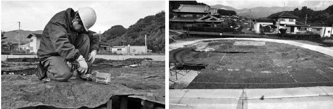
20 接合部裏面強化…仮接合したFRP 雄型の移設部材の境界部の裏面にFRP をあてがいポリエスチル樹脂を塗布して、その硬化により各部材同士を接着することにより各部材の位置関係を固定する。
