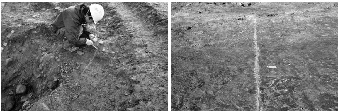
**22 欠損部造形**…FRP 雄型の部材のうち設置坑内に設置不可能な部分の切断・除去と欠損部の FRP の地面を造形により追加制作する。また、雨水排水用に FRP 雄型部材をドリル等に穿孔する。
