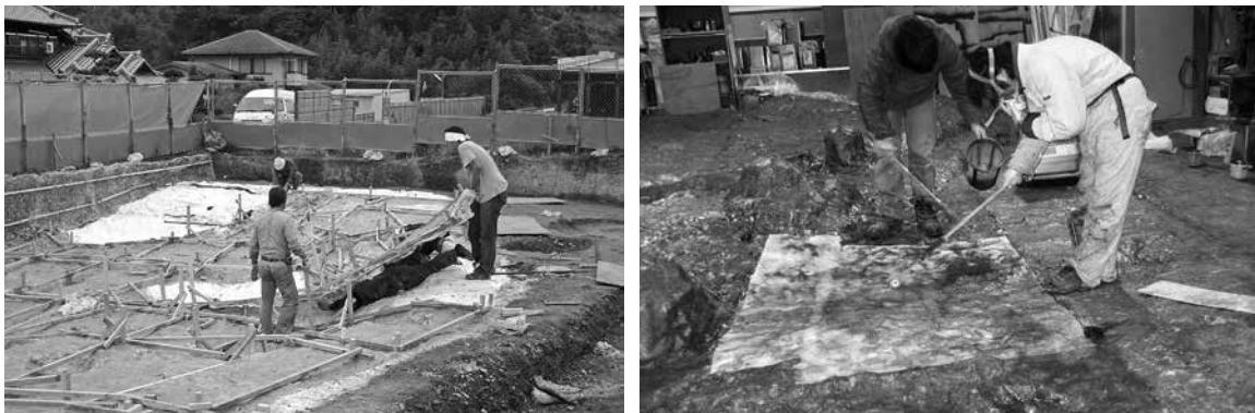
**6 剥き取り**…立体形状の型取り（雌型）の脱型したのち、建物表面に塗布したシリコン樹脂を取り外して、建物の表面の土や石が接着したシリコン樹脂の剥き取りを行う。
