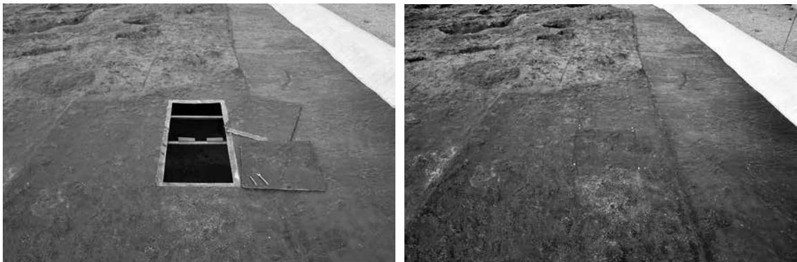
**24 設置坑内固定**…FRP 雄型の移設部材と設置坑内法面のコンクリートの設置部分を裏面から FRP と樹脂で接着固定し、表面目地を变成シリコンコーティングで間詰めを行い、ネット養生を行う。
