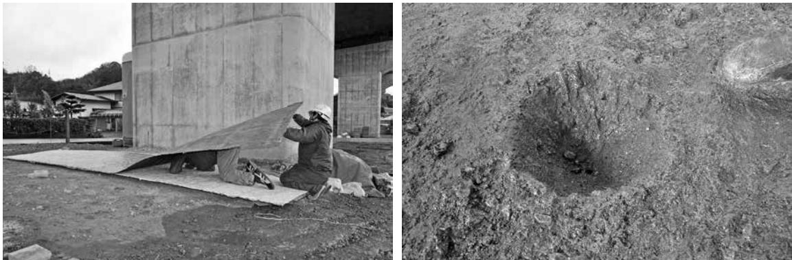
**23 下部出入り口設置**…FRP 雄型の移設部材下部への出入り口を確保するために、部材の一部を  $0.6m \times 1.6m$  角に切り抜いてナットボルトによる開閉式の出入り口を設置する。
