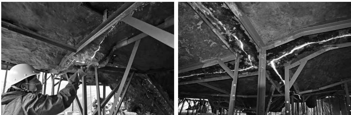
21 接合部表面処理…FRP 雄型の移設部材境界部にある表面の目地に、顔料を混ぜて周辺土壤と同系色にした樹脂を間詰めし、調和した建物のFRP 雄型表面を制作する準備を行う。
