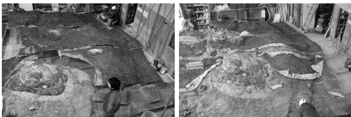
**10 骨組み制作**…土付き雌型上に塗布したFRPの変形防止を目的として、FRPをスチール製骨組みで補強する。さらに、骨組みに付ける支脚高さ調整を行い、建物の立体的位置関係を復元する。
