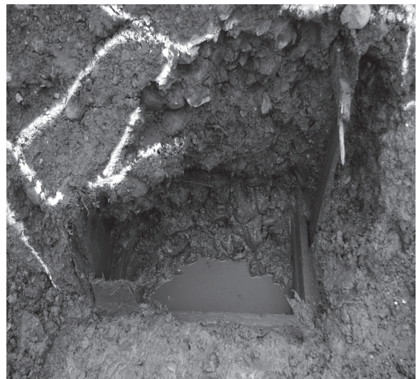
図36 井戸掘削状況（北から）
