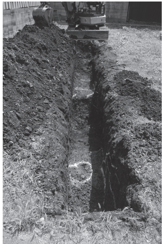
図61 調査区全景(南西から)
