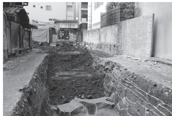
図10 埋め戻し風景（南から）
