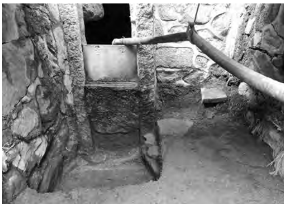
図21 樋門調査区(東から)
