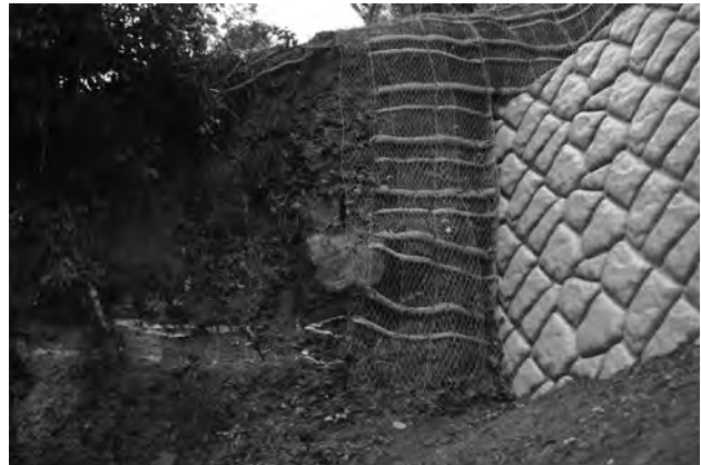
図77 No.1 石垣検出状況（東から）
