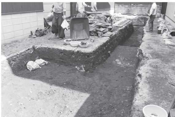
図4 作業風景(北西から)
