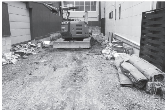
図3 重機掘削状況(北から)
