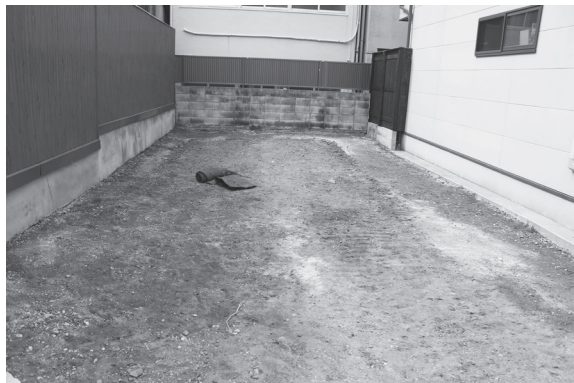
図5 埋め戻し状況(北から)
