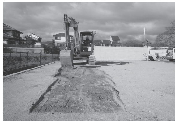
図3 機械掘削作業状況（東から）
