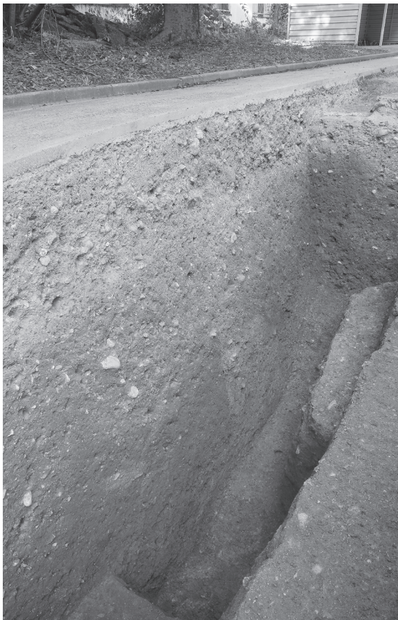
2 1c区北壁（南西から）
