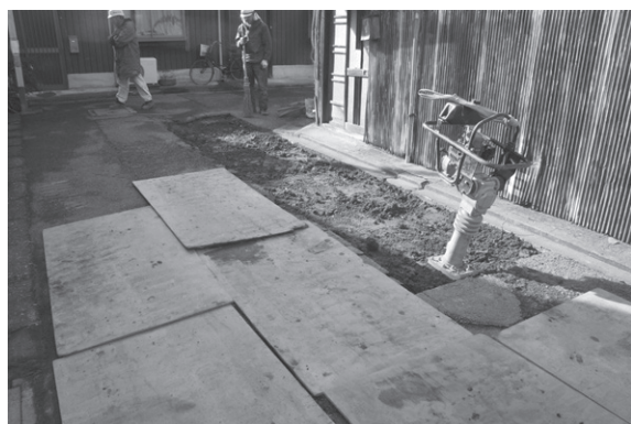
図5 埋め戻し状況(北東から)
