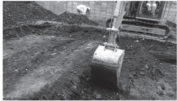
図2 重機掘削風景(東から)
