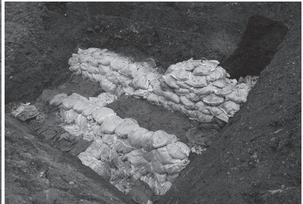
4 1区埋戻し状況（北西から）
