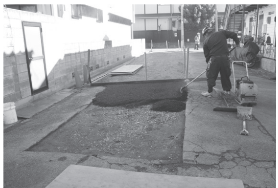
図6 道路舗装状況(西から)
