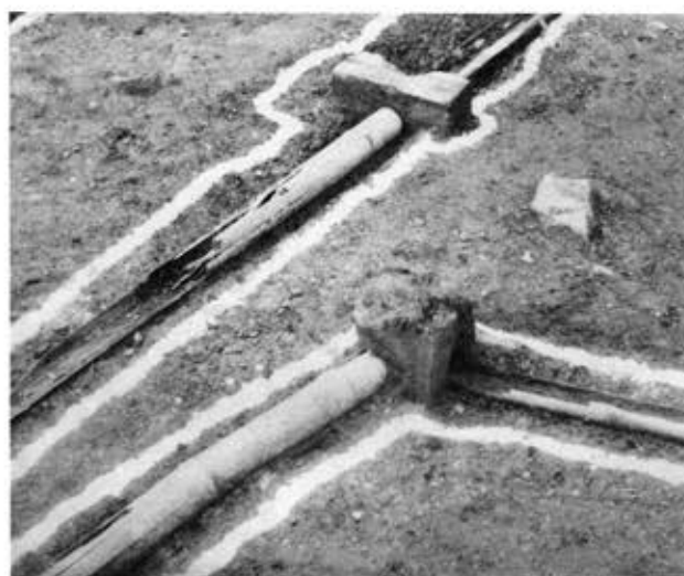
6 S D1002・1003継手部 (北東から)
