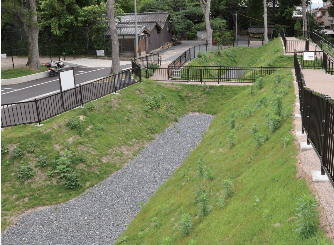
(1) 遊歩道が整備された東西土塁と土橋（西から）
