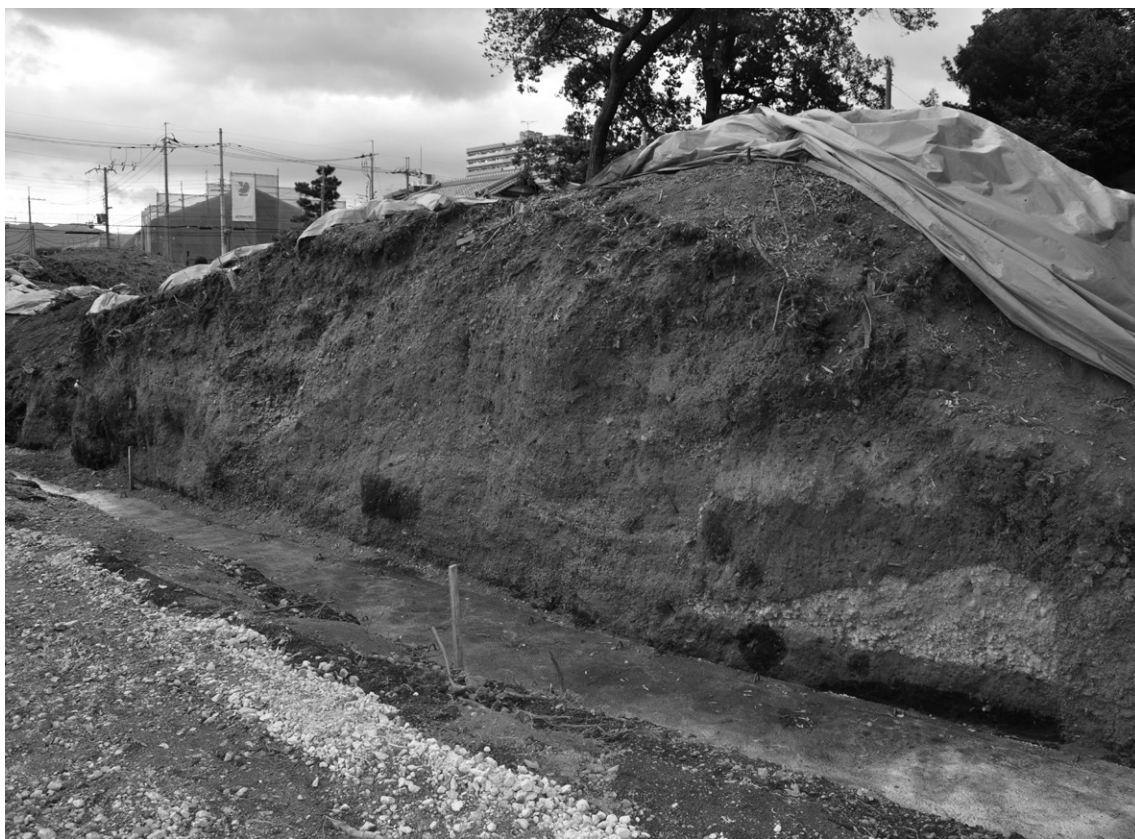
(2) 整備工事中の土塁崖面 (南東から)
