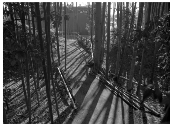
第6図 竹林に覆われた土橋(北から)
