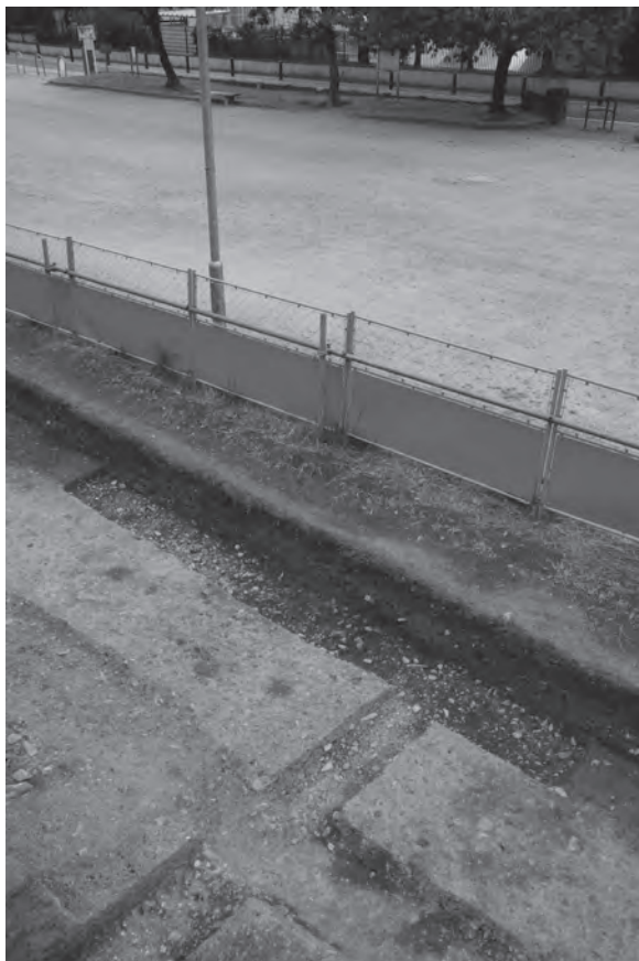
2 礫敷き整地層（北西から）
