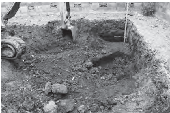
図3 人力掘削作業状況（北から）
