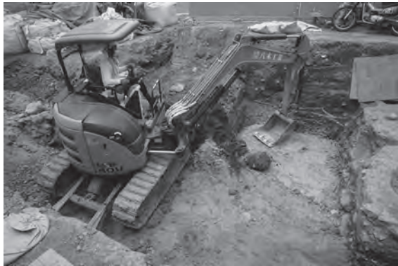
図5 埋戻し風景（北東から）
