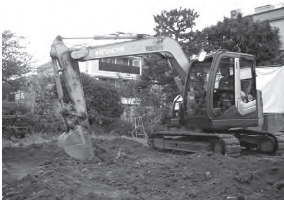
図2 重機掘削（北西から）
