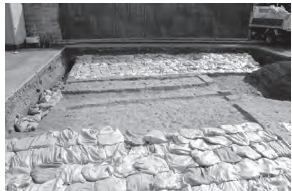
図6 第5調査区埋戻し状況 (西から)
