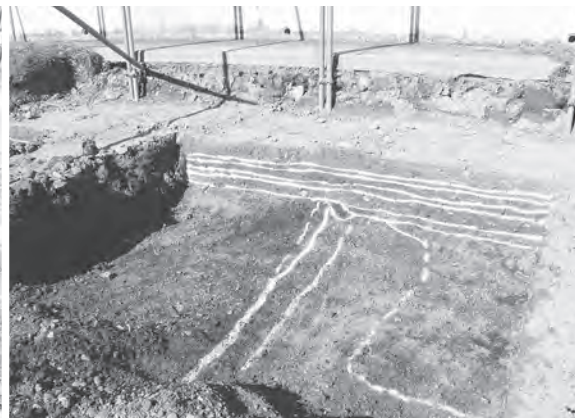
7 第6-10区全景(南東から)
