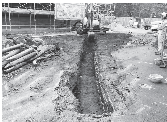
図2 試掘調査 重機掘削作業状況
