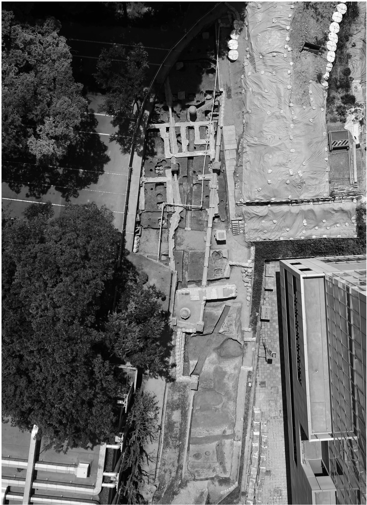
調査最終状況全景 2015年6月24日撮影(右側が北)
