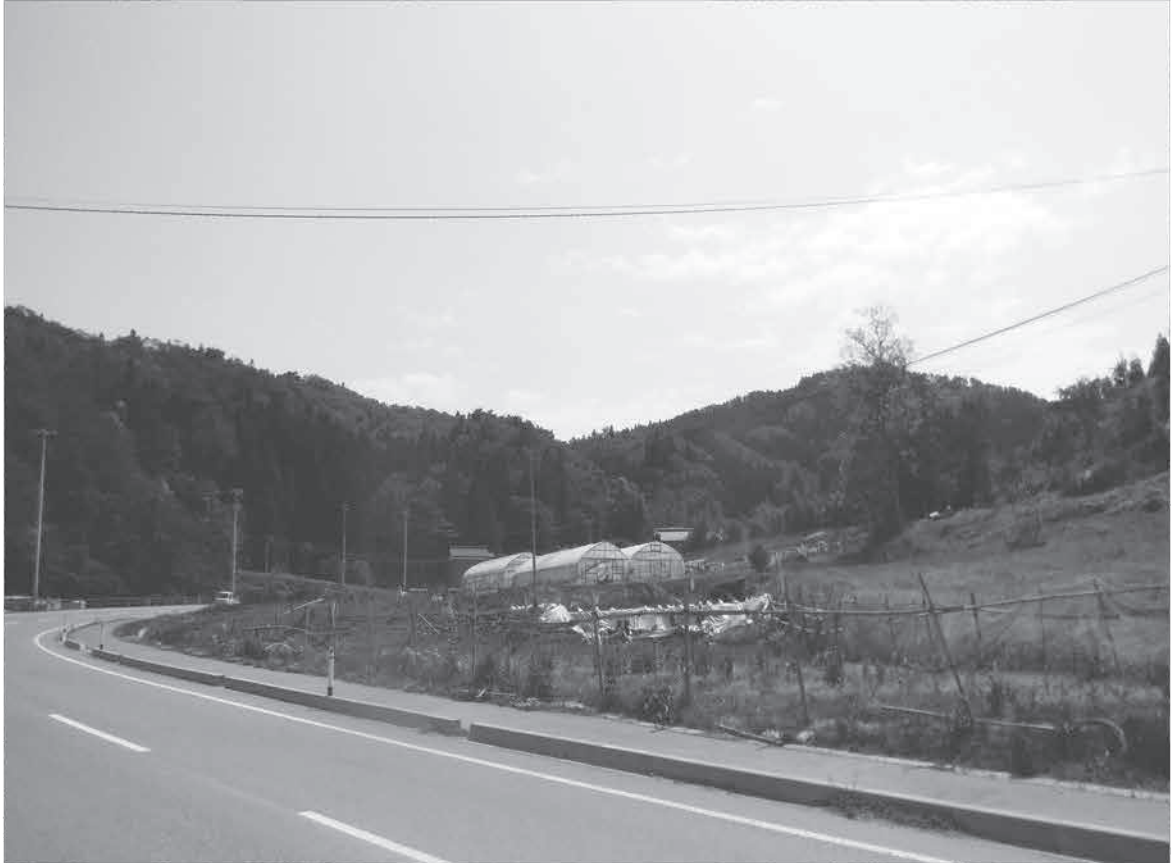
(1) 調査区遠景 (北より)
