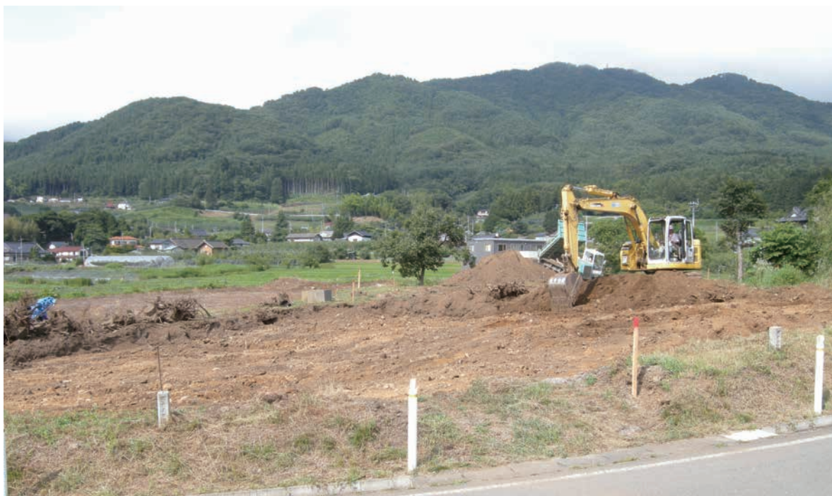
写真4 3区表土掘削状況
