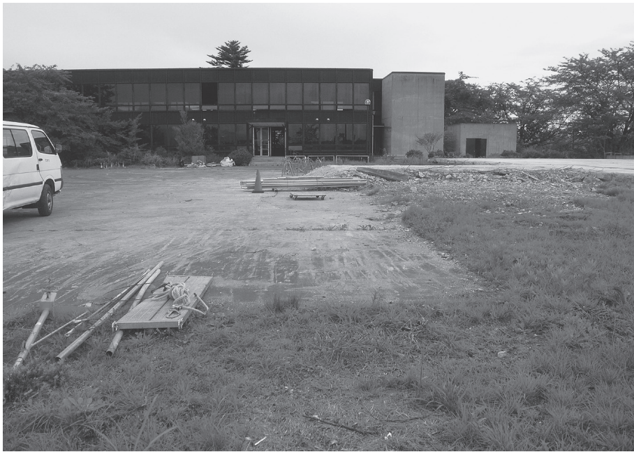
調査区調査前 近景（南から）
