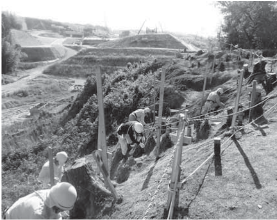
急傾斜面での作業風景
