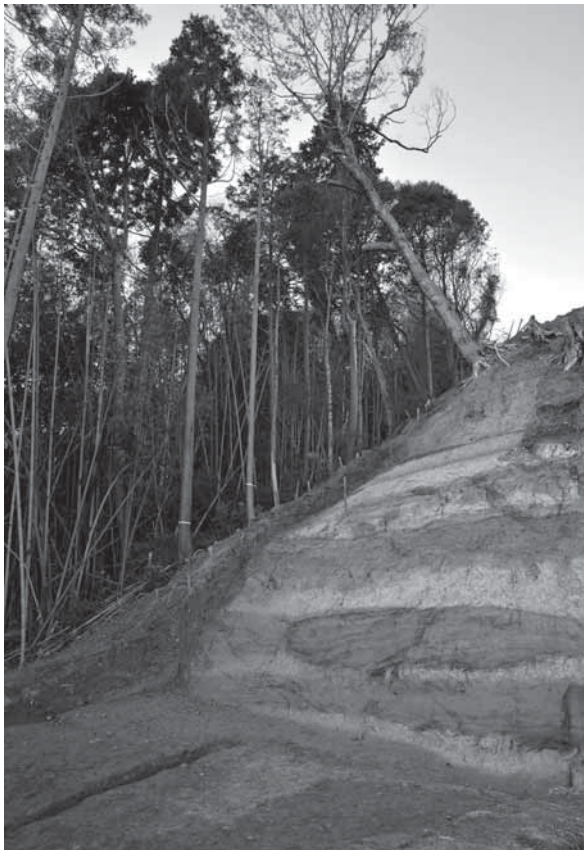
曲輪 2 東側の切岸（北東から）
