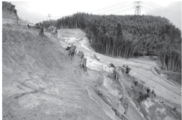
犬走状遺構 S Z 1035 (南から)
