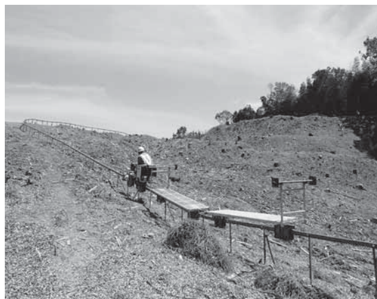
資材運搬用モノレール
