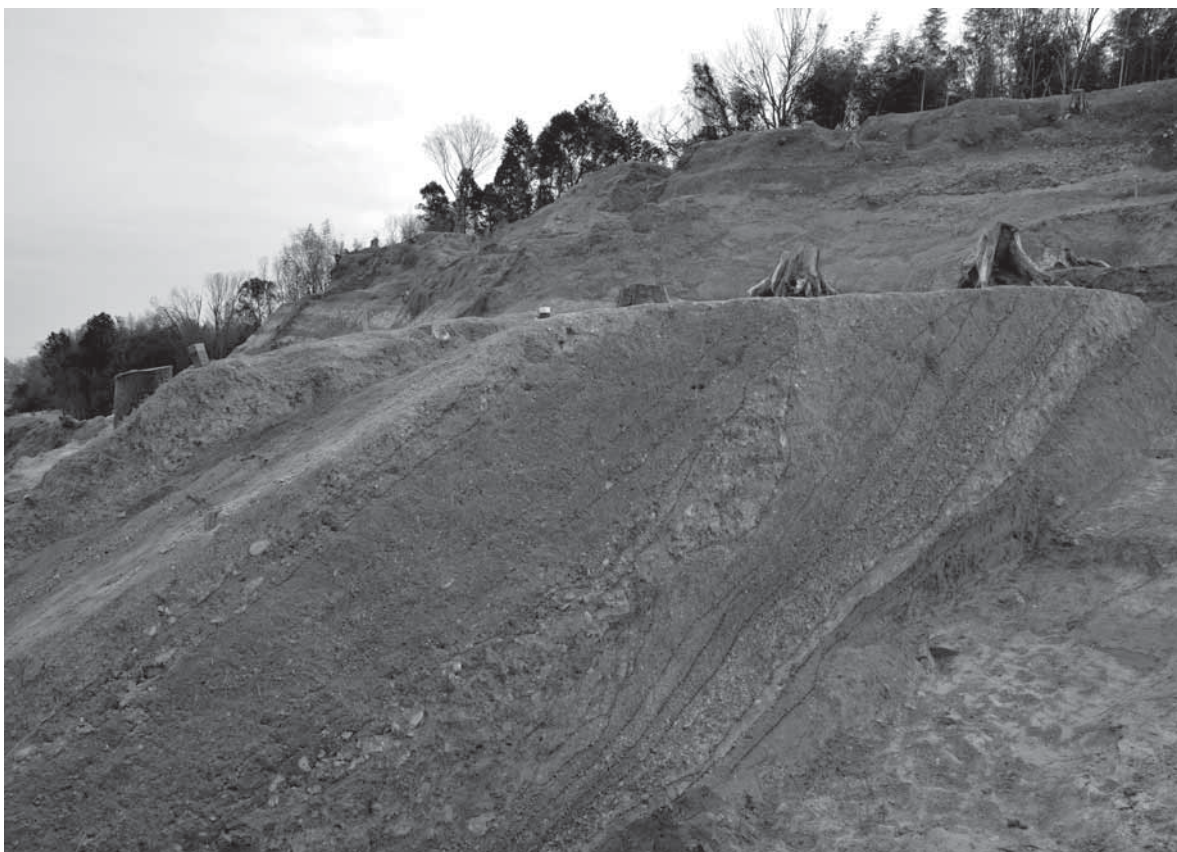
曲輪 11 断ち割り (北西から)
