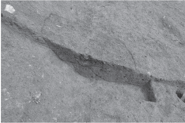
1 S063 段状遺構断面（南から）
