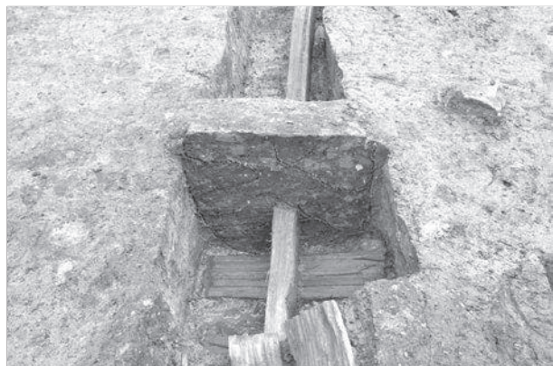
1 SB5 布掘北側断面（西から）
