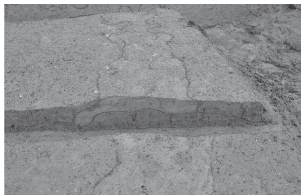
8 6区平地部南部畦畔3断面（東から）
