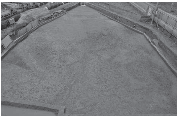
6 6区平地部北部第5遺構面完掘 (南から)
