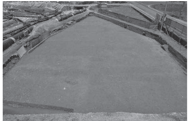
5 6区平地部北部第4遺構面完掘 (南から)
