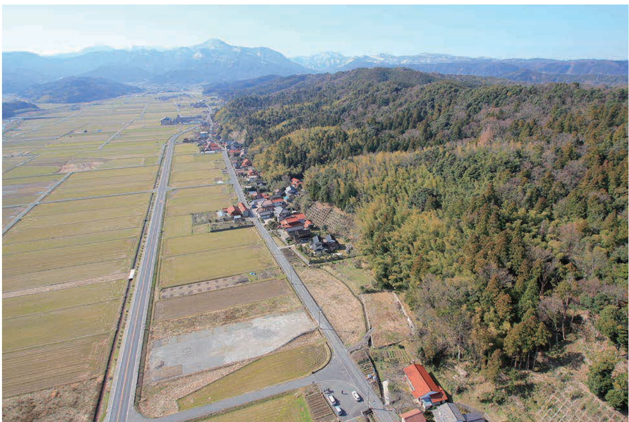
2 4～6区調査前遠景（北上空から）
