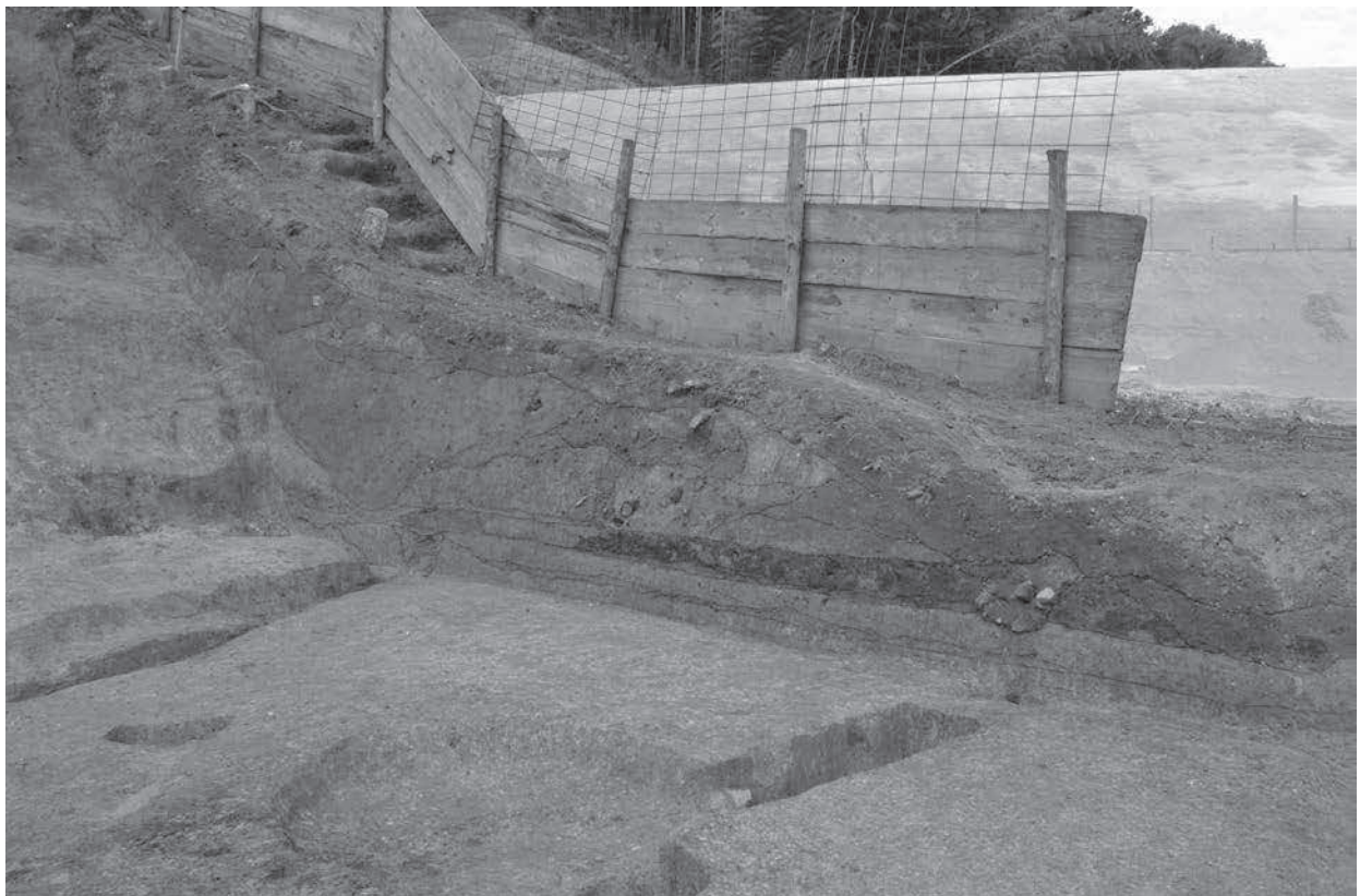
2 8区丘陵斜面部（エリア3）北壁断面（南から）
