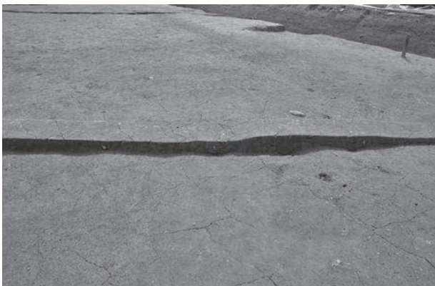
3 6区平地部南部畦畔1断面（北東から）
