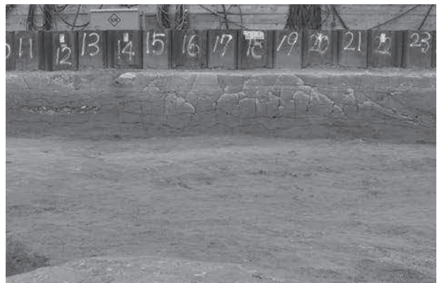
8 5区北壁断面 (南から)
