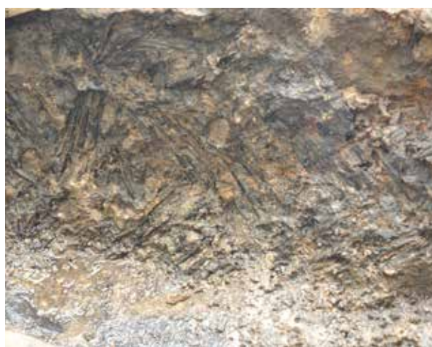
写真51 西壁内装細部
