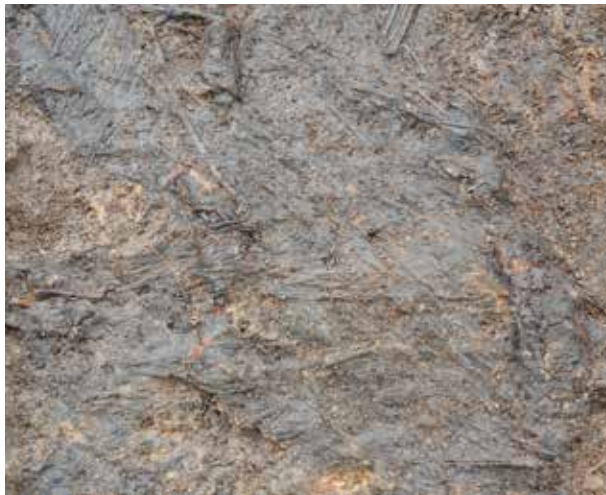
写真44 東屋根葺材細部
