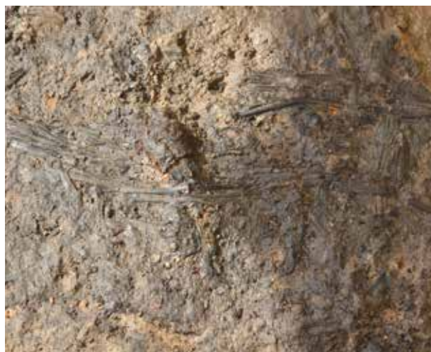
写真49 綿状葺材と格子下地
