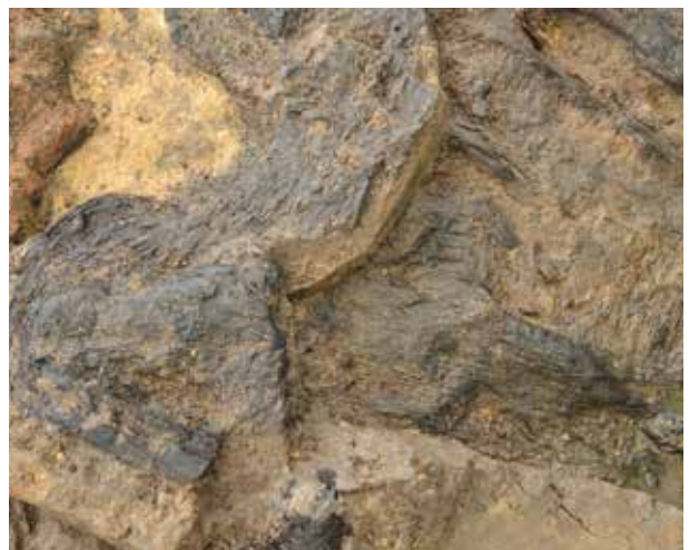
写真47 西屋根上部屋根飾り部分
