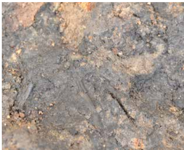
写真48 北屋根綿状葺材
