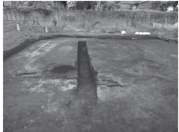
図版 3-5 敷領遺跡 16 次 建物跡検出 (東から)
