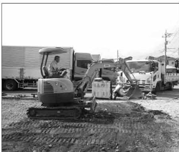
5. 埋め戻し (3トレンチ)
