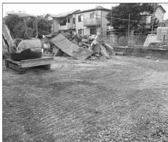
6. 埋め戻し (4トレンチ)
