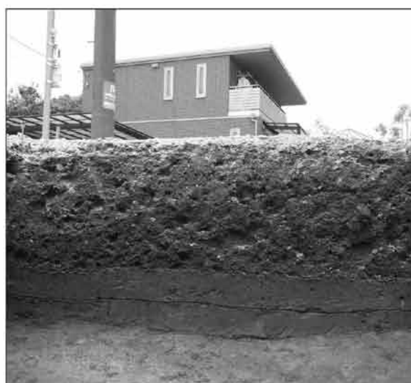
4. 断面 (3トレンチ)
