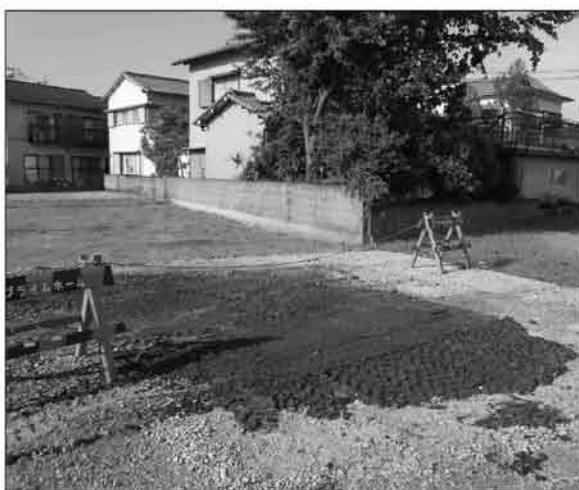
5. 埋め戻し後 (4トレンチ)
