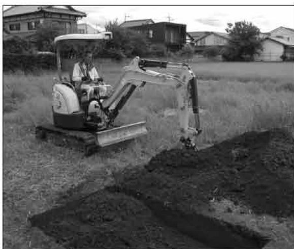
5. 埋め戻し (3トレンチ)
