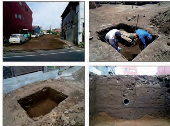
写真 調査状況
