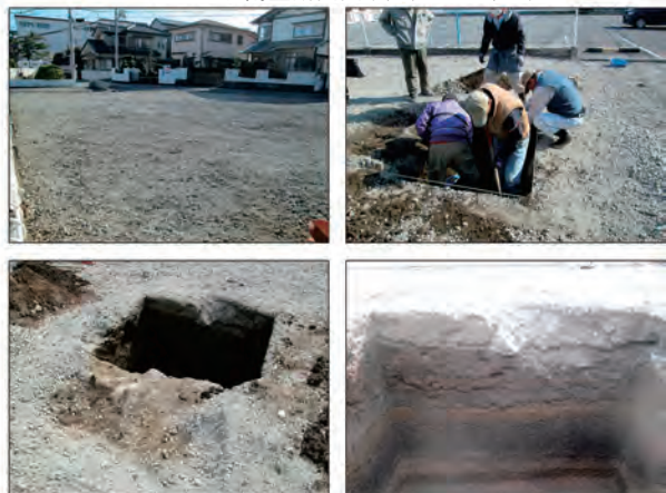
写真 調査状況
