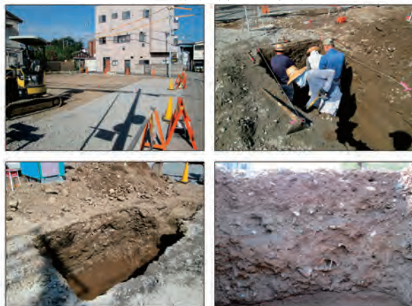
写真 調査状況
