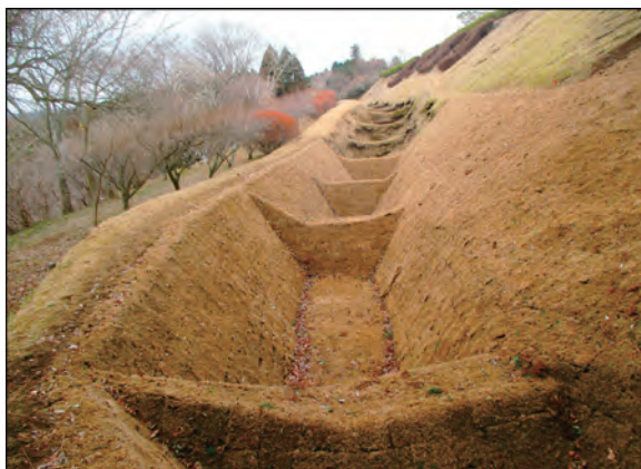
一ノ堀再整備状況
