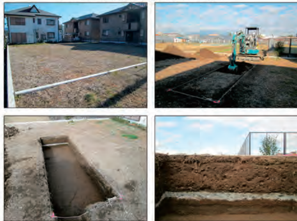
写真 調査状況
