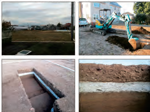
写真 調査状況
