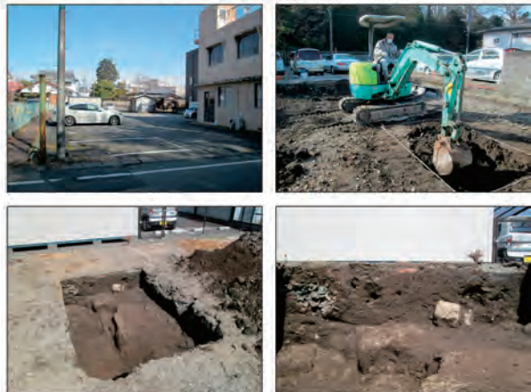
写真 調査状況
