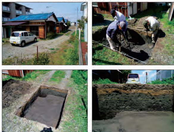
写真 調査状況
