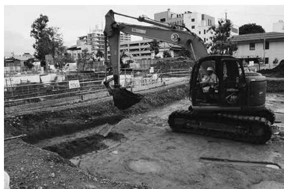
平成28年度調査表土掘削状況
