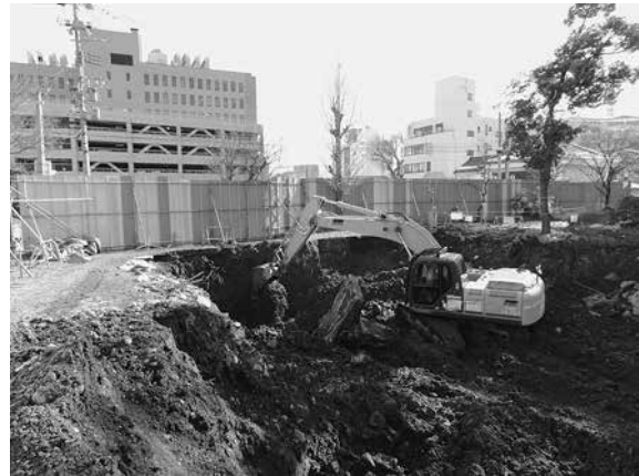
校舎解体工事（北西から）
