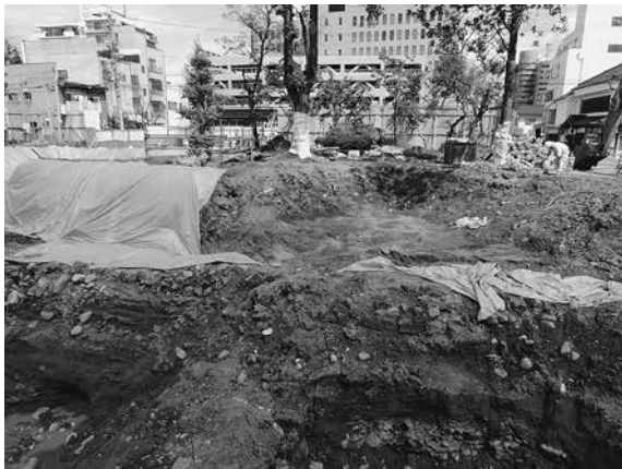
平成28年度中央棟工事立会い状況
