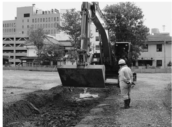
平成27年度調査表土掘削状況
