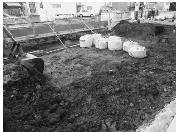
後町ホール雨水貯留槽掘削状況（北西から）
