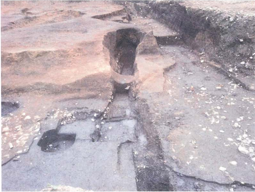
S D402 暗渠排水溝（西から）
