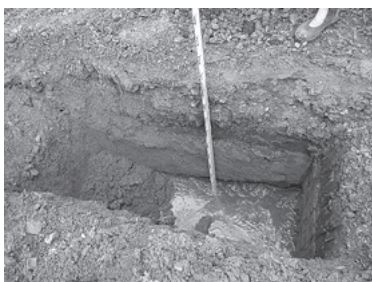
写真111 3T断面(SE→)
