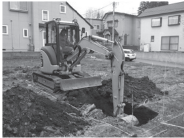
写真13 調査風景(NE→)
