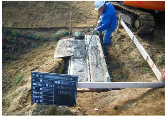
橋基礎コンクリート打設状況 (N→)
