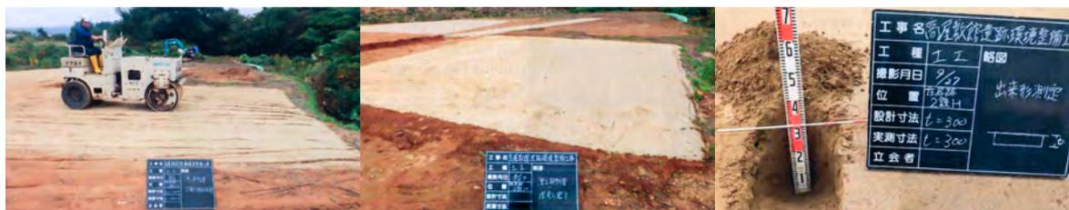
2鉄H凍上抑制層転圧状況 (S→)
