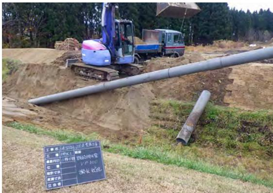
旧作業用仮設道路（壕）既設排水管撤去状況（N→）
