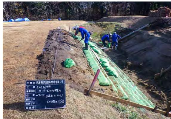
旧作業用仮設道路（壕）植生土のう設置状況（W→）
