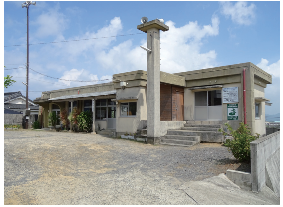
1 - 写真 02 兼久集落自治公民館
