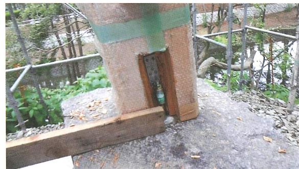
柱脚部 引寄せ金物の取り付け
