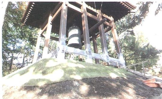
法面保護のため芝生張り
