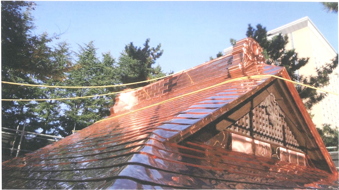
屋根銅板葺き完了
