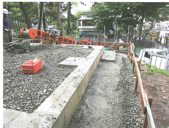
基礎内部埋戻し
