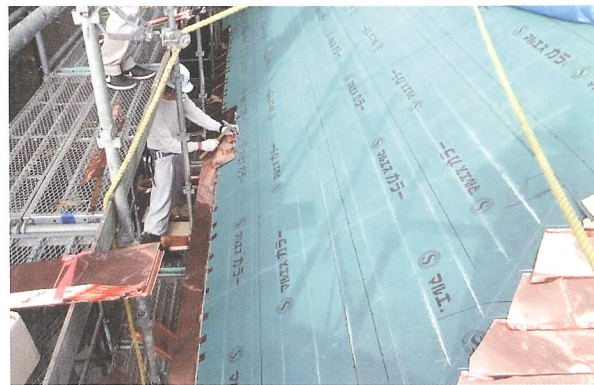
軒先部の銅板張り作業
