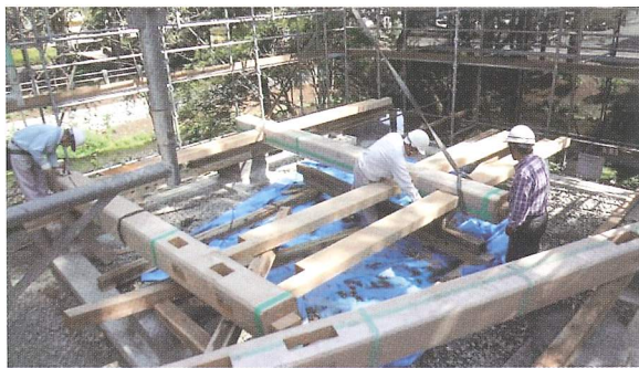
建て方 (柱・貫の地組み)
