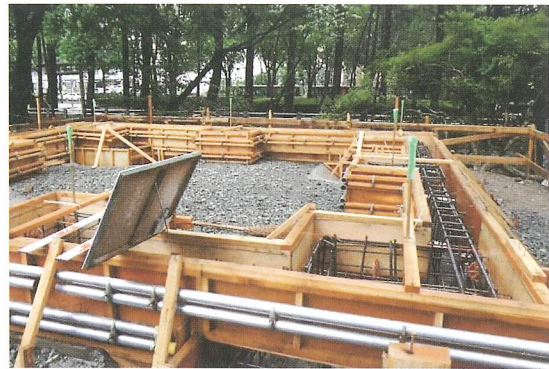
型枠設置状況
