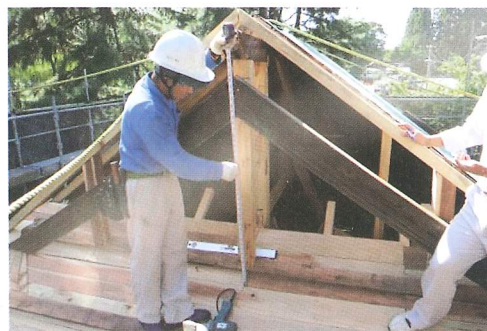
妻側の破風板取り付け
