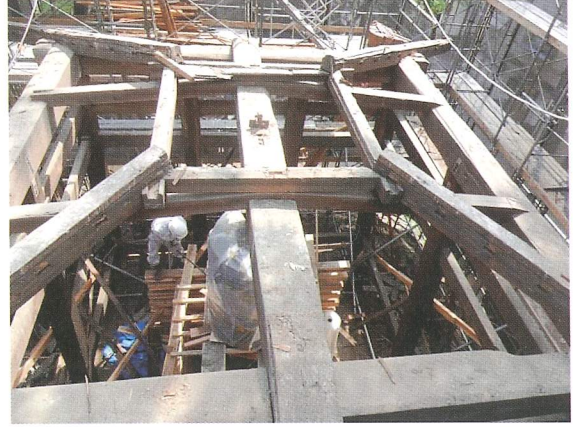
化粧垂木撤去後の状況 材の状態は大きな劣化が少ない。
