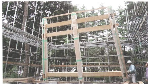
クレーンによる建て起こし
