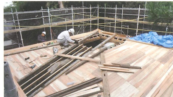
化粧野地板の施工
