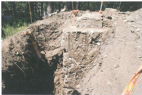
ラップルコンクリート施工状況確認
