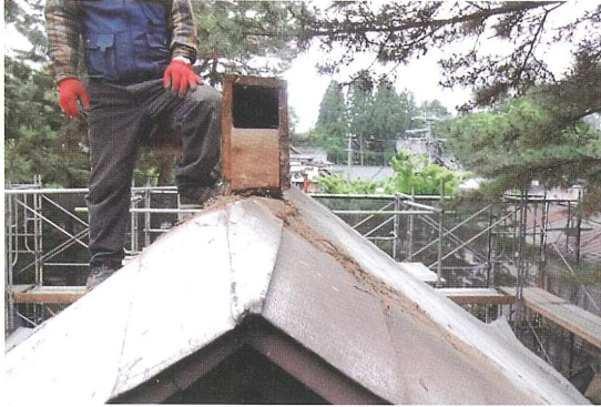
箱棟トタン撤去状況
