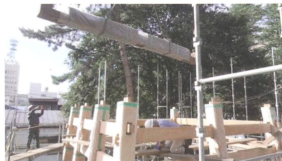
梁・桁の組み立て
