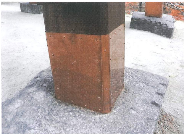
柱脚部分の銅板巻き
