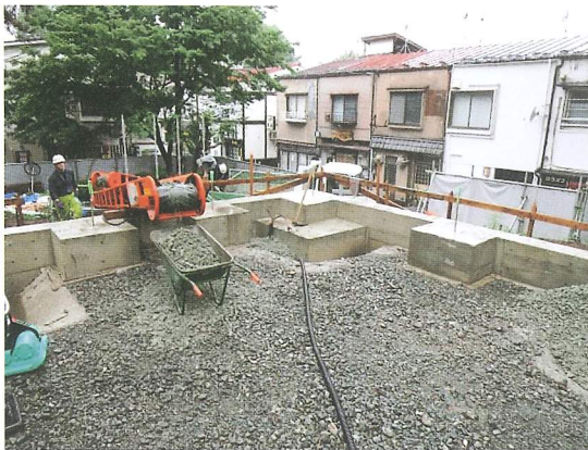
基礎コンクリート出来形
