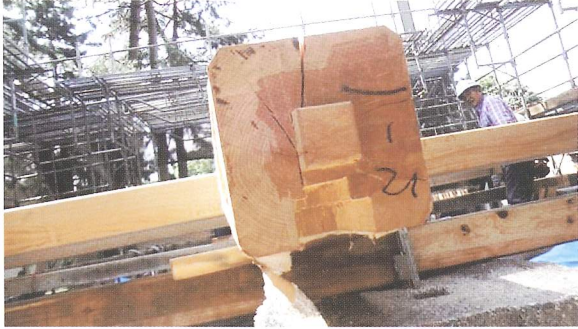
柱脚の加工状況
