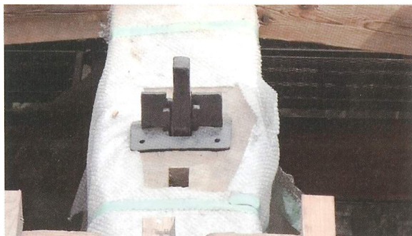
時鐘上部の吊り金物（既存）
