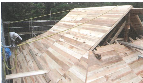
野地板の取り付け
