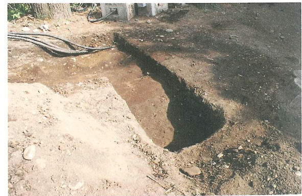
Aトレンチ（北西から）
