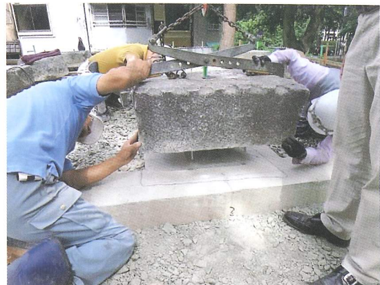
礎石の据え付け状況
