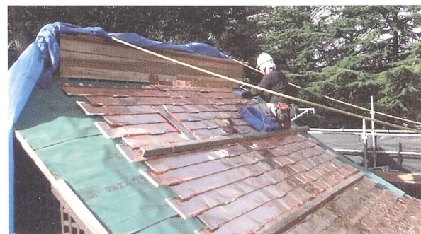
箱棟銅板張り作業状況
