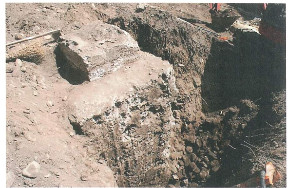
ラップルコンクリート施工状況確認
