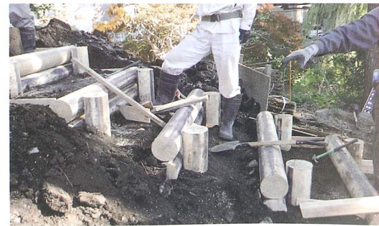
階段の設置（栗材を使用）
