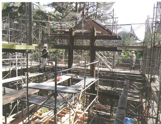
桁撤去作業
