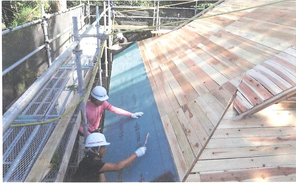
屋根 (アスファルトルーフィング張り)
