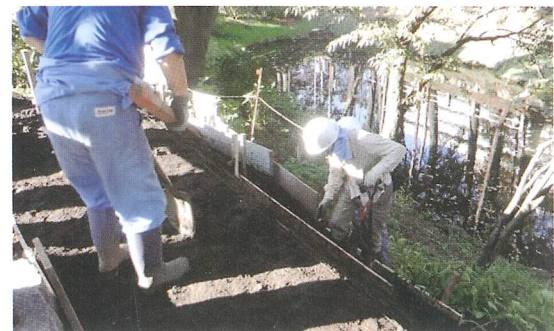
法面の整形状況
