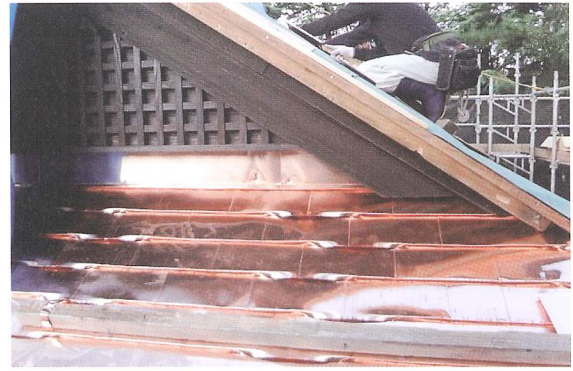
妻壁銅板の納まり
