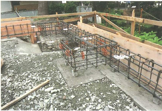
基礎配筋状況
