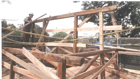
小屋組の状況（小屋貫は全て交換）
