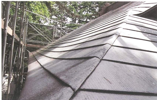
屋根隅棟部分
