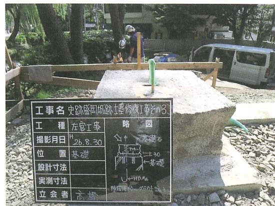
金物周囲及び基礎空隙部にグラウト材を注入して完了
