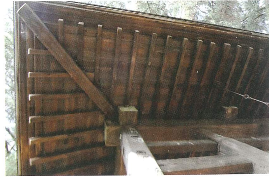
軒先、天井の状況
