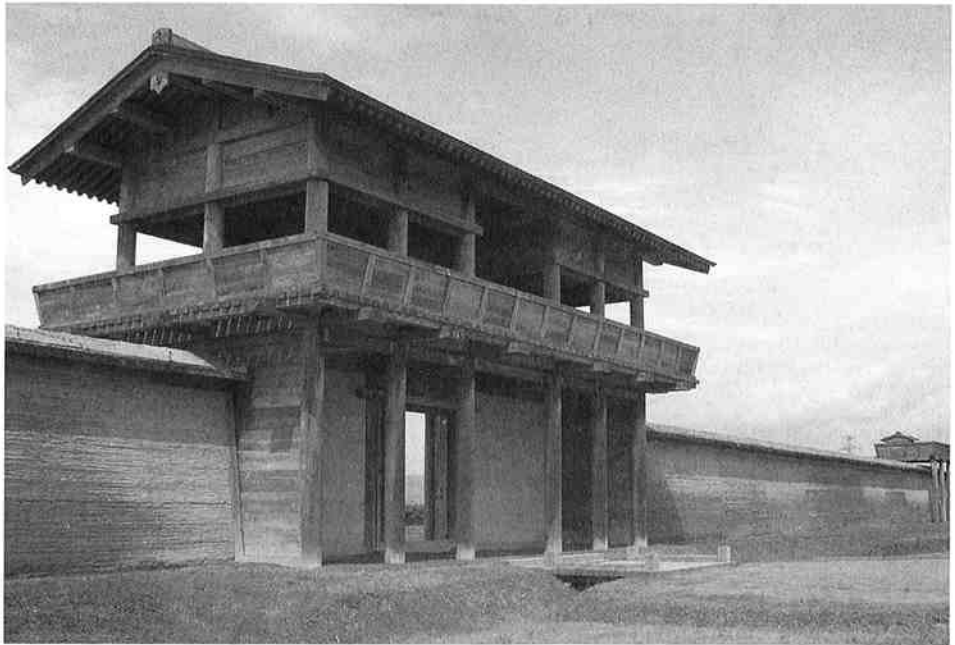
外郭南門・築地塀・櫓 復元建物
