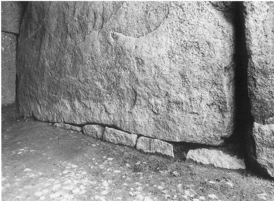
羨道東壁基底部の填石状況 南西から
