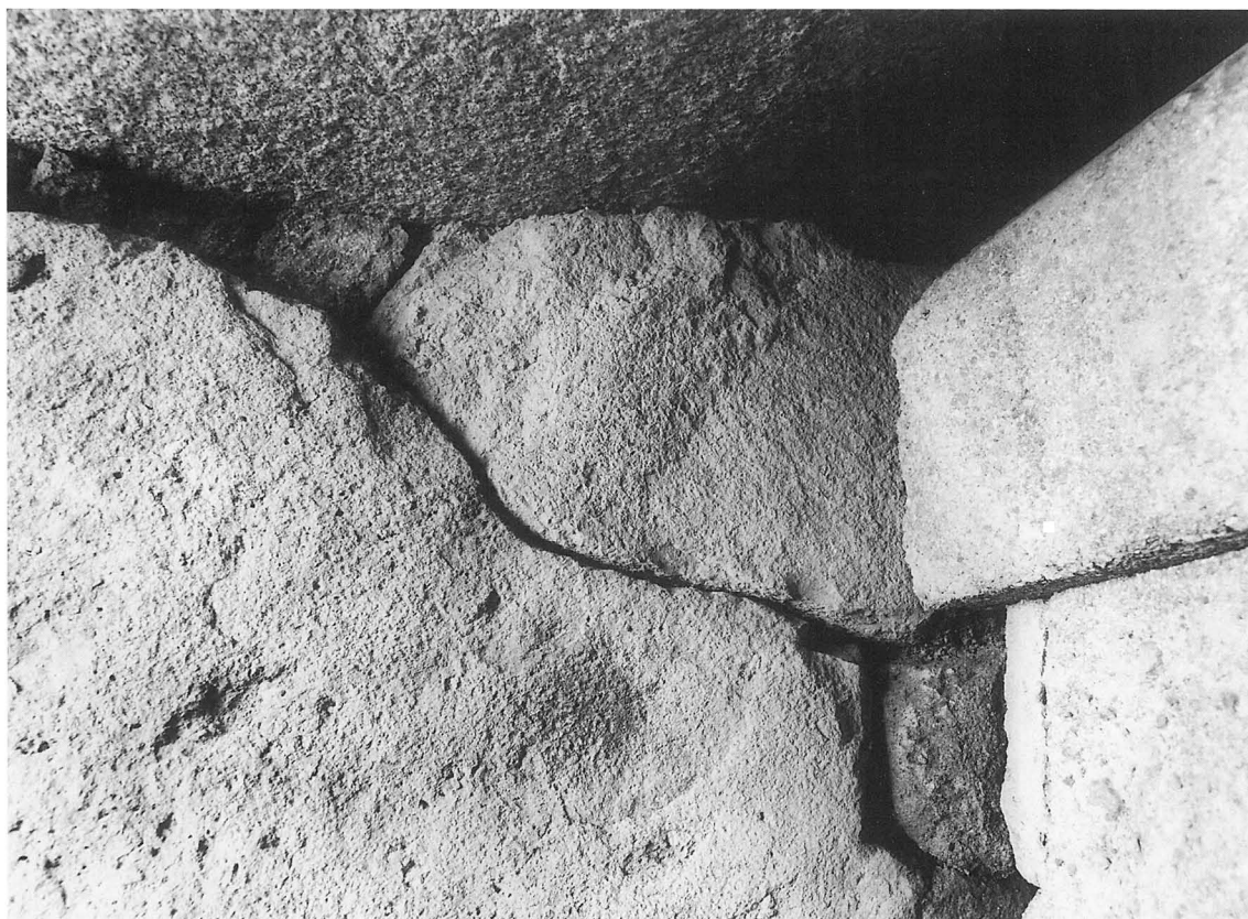
石槨と西壁の構築状況 南東から
