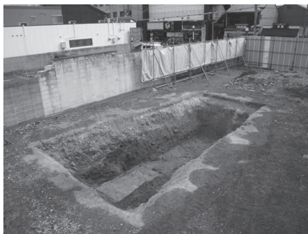
HJ 第 678 次調査 南発掘区全景 (北西から)
