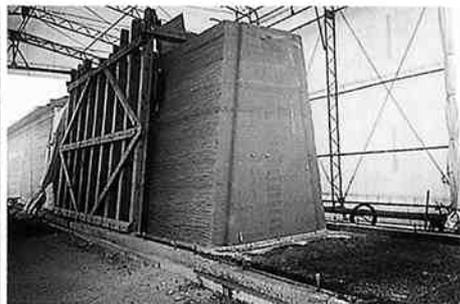
版築完了・仮枠移動
