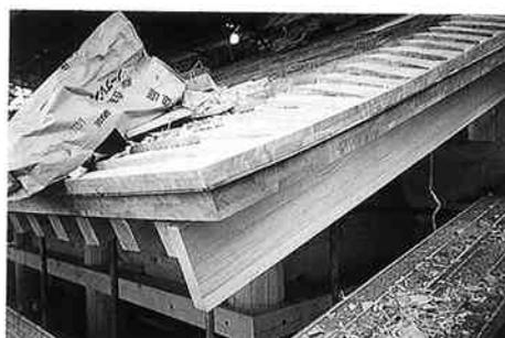
葺葺軒先詳細・破風板
