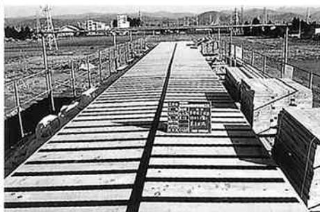
屋根板葺き込み・防水テープ施工
