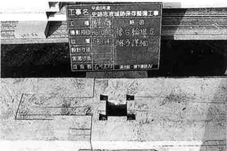
桁行台輪継手詳細
