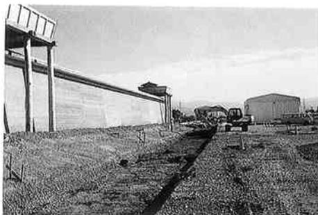
土工事：築地線・溝整形
