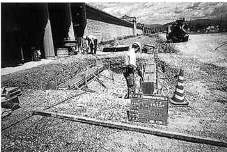
橋設置工事：基礎コンクリート打設
