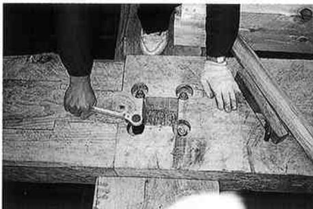
柱頭部補強ボルト締め
