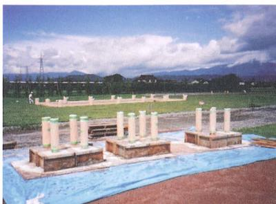
柱表示部基礎コンクリート打設
