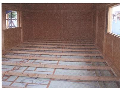
床下配線・配管, 根太取付
