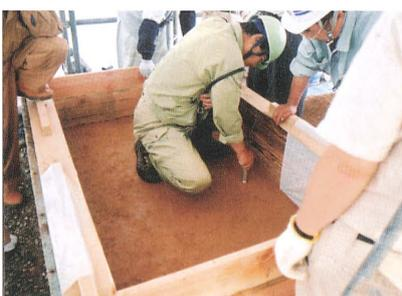
試験施工（突堅め状況確認）
