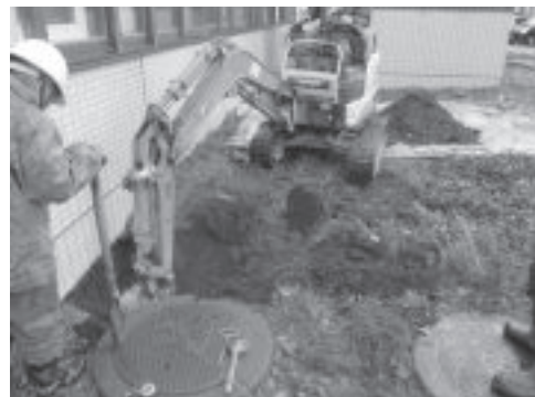
H. 大学病院病棟屋外排水管修理工事(東より) 1613
