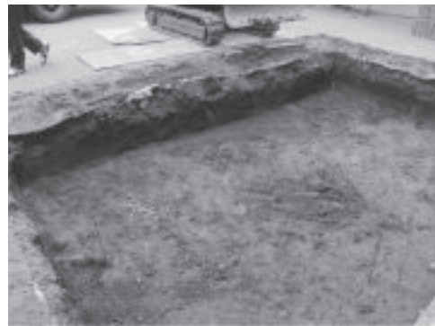
D. 総合博物館バリアフリー工事(北西より) 1606
