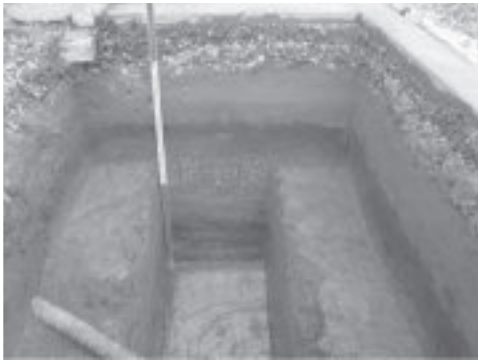
A. 獣医学研究科支障配管切り回し(排水管等)工事 TP01 西壁 1605
