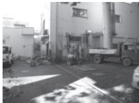
F. 福利厚生会館ボイラーブロー配管修理工事 (西より) 1610
