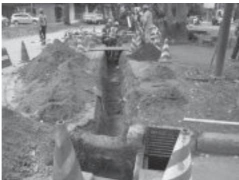
G. 中央道路雨水枡設置工事(東より) 1611
