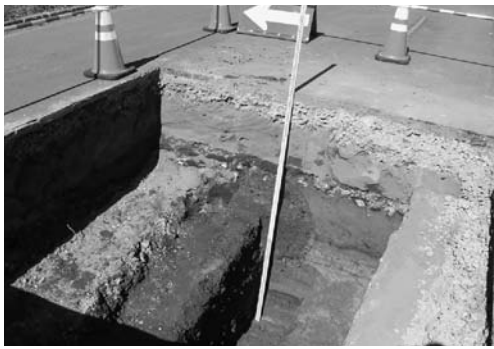
A. 医学部雨水排水施設整備工事 TP 07 東壁 1410
