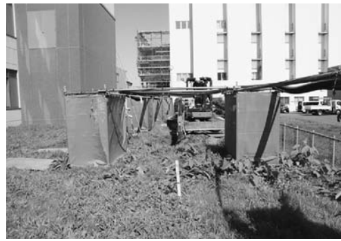
B. フード&メディカルイノベーション国際拠点棟 屋外設備工事調査箇所（南から）1417
