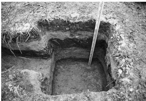
N. 畜産製造実習室新営機械・電気設備工事外灯基礎立会 東壁 1025
