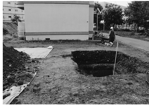
J. 桑園国際交流会館新営工事 TP 14 周辺の調査状態（東から）0827
