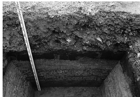
L. 電子科学研究所工作室改修工事 TP 06 南壁（北から）0832
