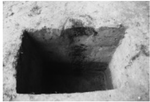
2. HP 01 SPT 03 (断面状態：南より)
