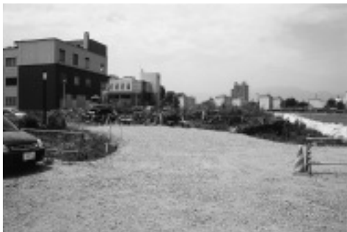
C. シオノギ共同研究棟 (創薬基盤技術研究棟) 建設に伴う設備工事予定地調査状況 (東より) 0709
