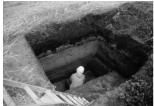
F. インキュベーション研究施設建設工事予定地 TP 03 調査状況 (西より) 0622
