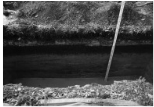
J. モデルバーン給水管工事予定地 TP 07 西壁
