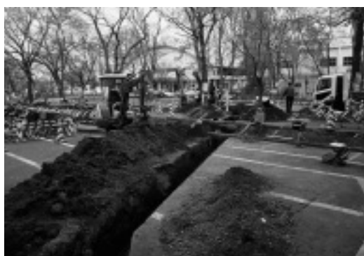
A. 創成科学研究棟等新営電気設備工事予定地 TP 03 掘削状況 (西より)
