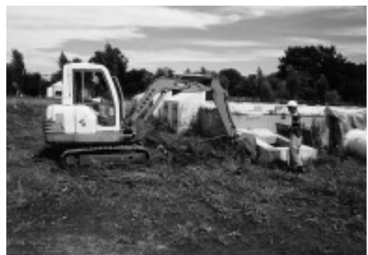
P. 中小家畜生産研究施設柵設置工事掘削状況（南より）
