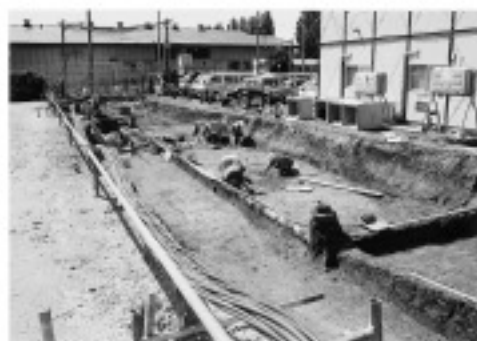
4 西区調査状況 (東より)
