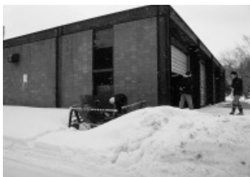
R. 事務局大型車庫蒸気管修繕工事掘削状況 (北西より)
