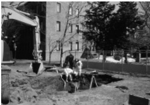
M. 北海道大学予科記念碑建立工事掘削状況（南西より）
