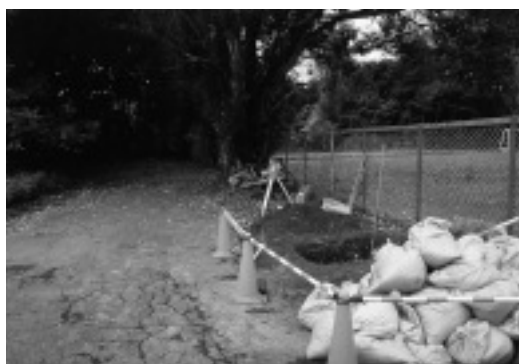
E. サークル会館～言語文化部電灯設置工事予定地 TP 05 調査状況 (南より)
