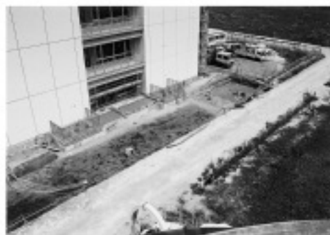
8 東区調査状況 (南西より)
