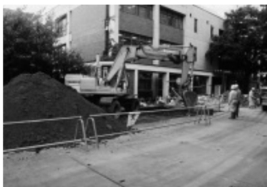
C. 医系総合研究棟新営貯水槽工事予定地調査状況 (南西より)
