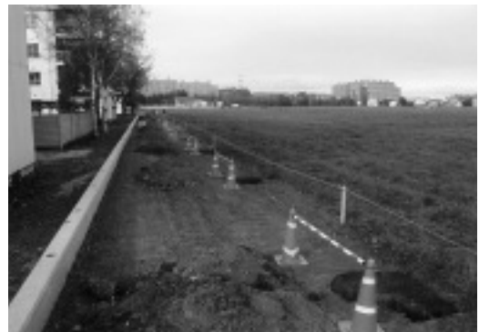
4. 試掘状況（南西より）
