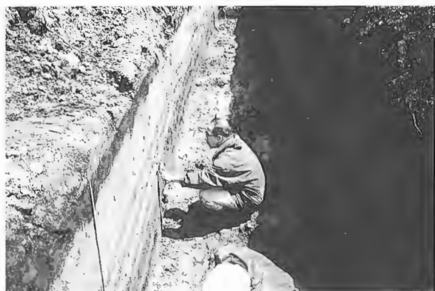
写真 13 理学部校舎新営工事予定地（北より）
