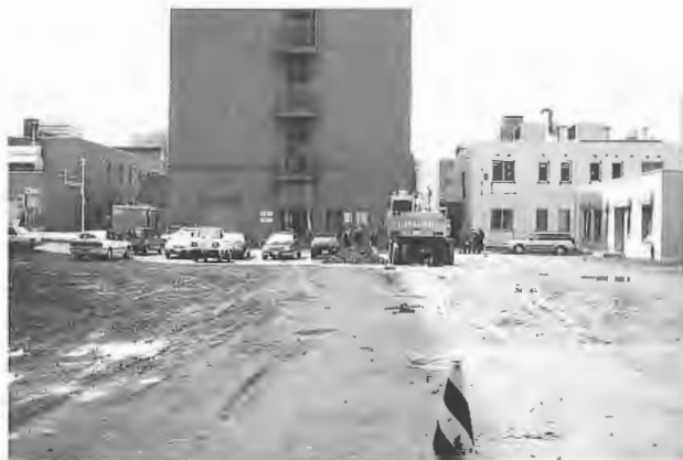
写真 14 理学部校舎新営工事予定地（北より）
